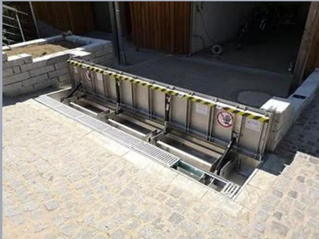
Bsp. Automatisches Klappschott (Quelle: Hochwassersicherheit)
