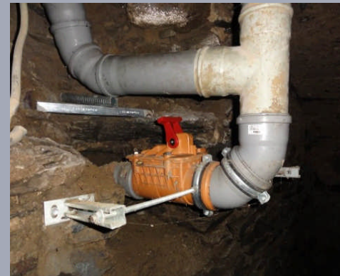
Rückstauklappe (Heisler 2011)
