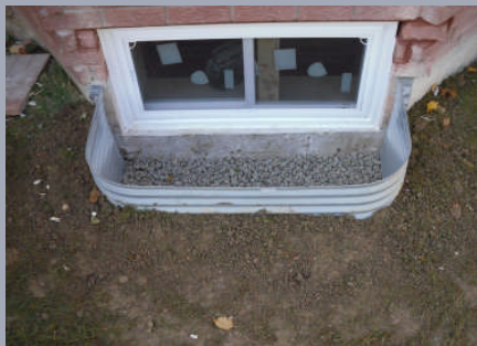
Bsp. Kellerfenster mit Umrandung (Quelle: Wikipedia)
