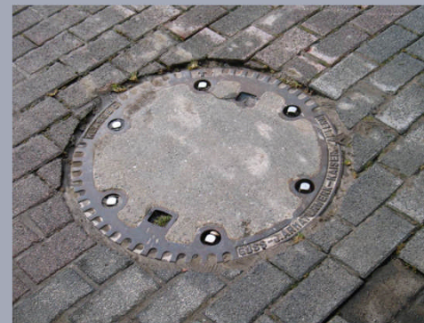
Verschraubter Kanaldeckel (Gretzschel 2010)
