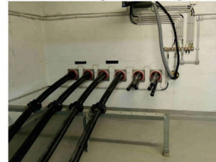
Leitungsdichtung
