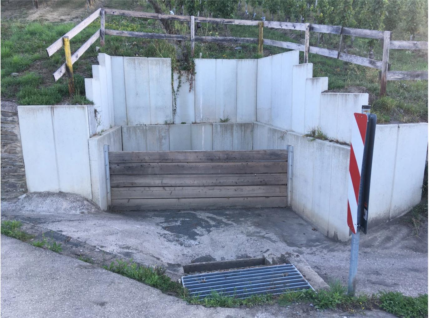
**ABBILDUNG 17: SANDFANG EINES ABLEITUNGSGRABENS IN WALDRACH (FOTO INCA, 2021)**
