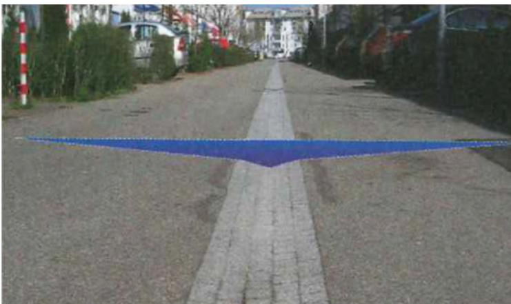
ABBILDUNG 28: STRASSE MIT INVERSEM DACHPROFIL (DWA, 2013)
