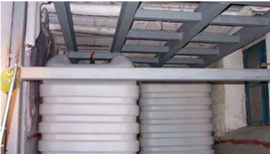
**ABBILDUNG 10: HEIZÖLTANKANLAGE MIT AUFTRIEBSSICHERUNG (QUELLE: HOCHWASSERSCHUTZFIBEL, 2018)**
