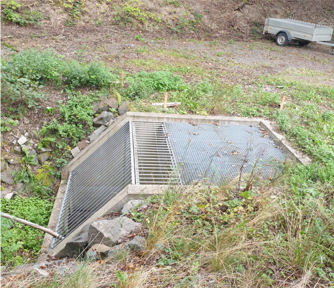
ABBILDUNG 19: HYDRAULISCH OPTIMIERTER EINLAUF IN KASEL (FOTO INCA, 2021)
