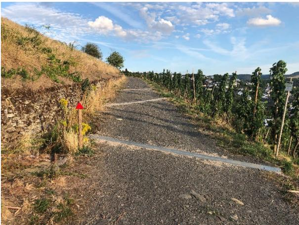
**ABBILDUNG 23: MEHRFACHE KLEINRÄUMIGE WEGEABSCHLÄGE (FOTO INCA,03.09.2022)**
