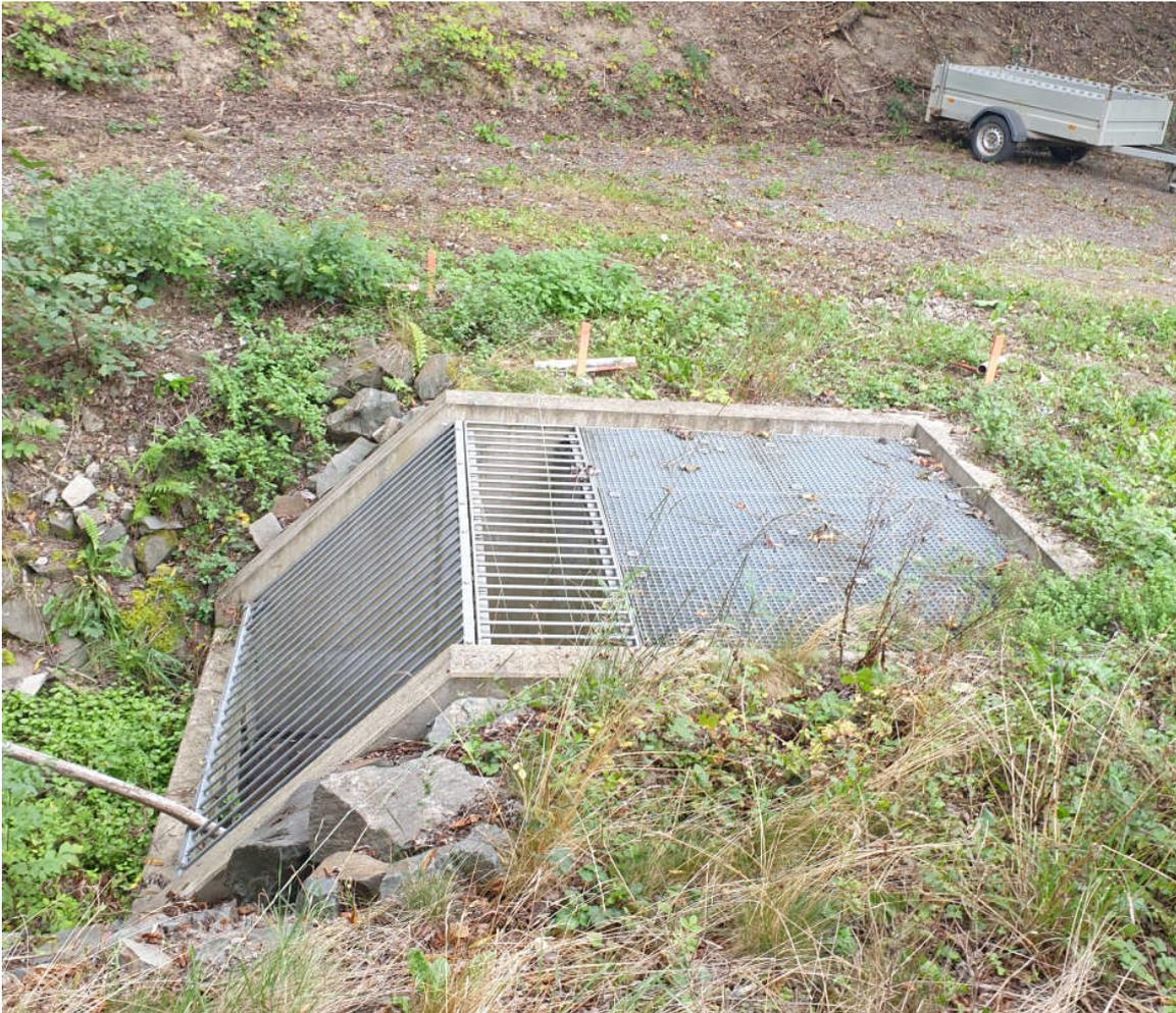
ABBILDUNG 24: HYDRAULISCH OPTIMIERTER EINLAUF IN KASEL (FOTO INCA, 2021)
