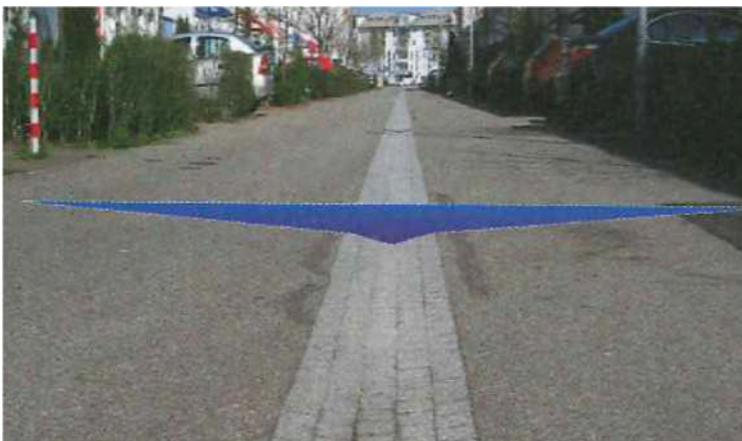
ABBILDUNG 33: STRAÙE MIT INVERSEM DACHPROFIL (DWA, 2013)
