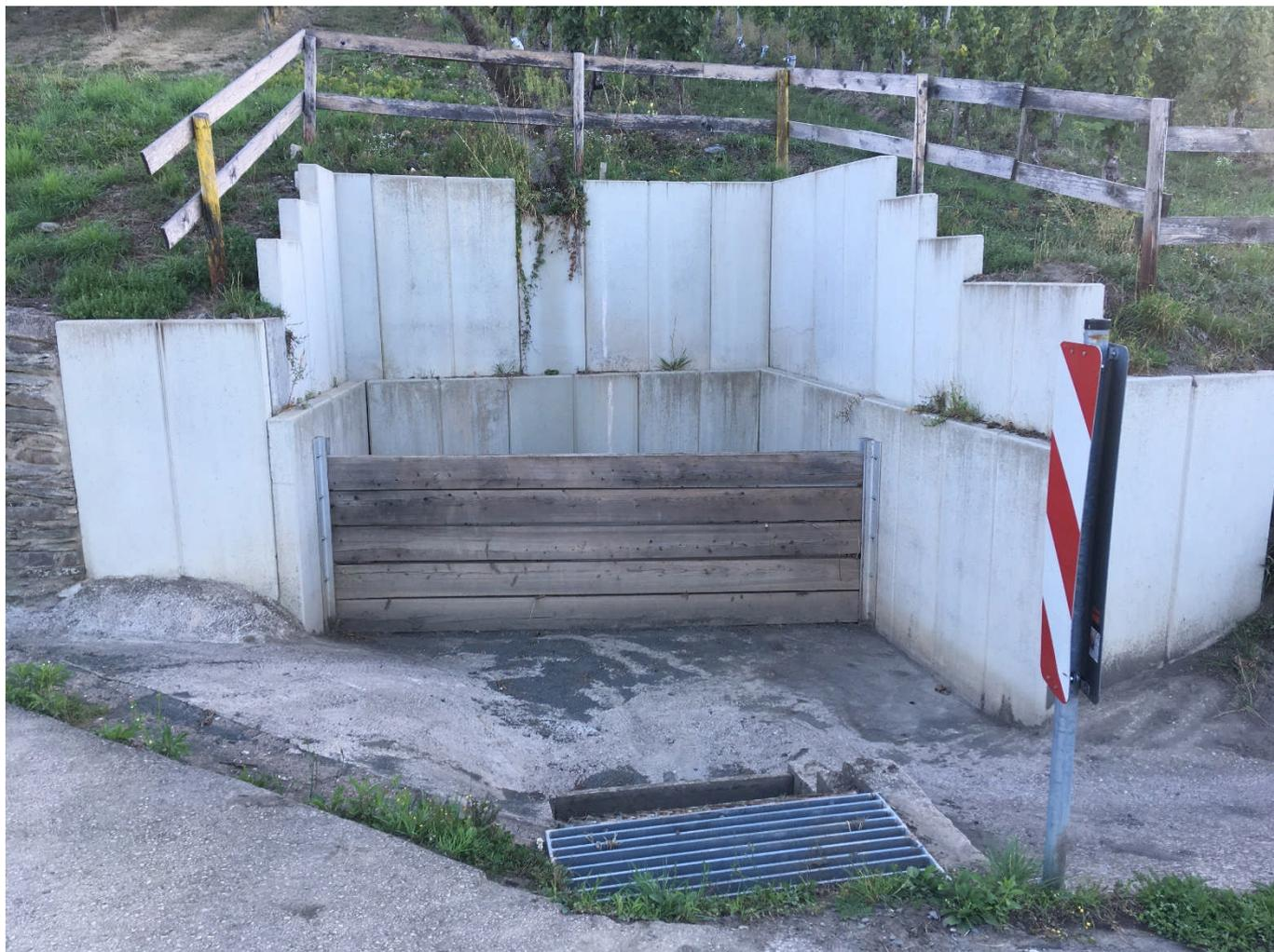
**ABBILDUNG 22: SANDFANG EINES ABLEITUNGSGRABENS IN WALDRACH (FOTO INCA, 2021)**
