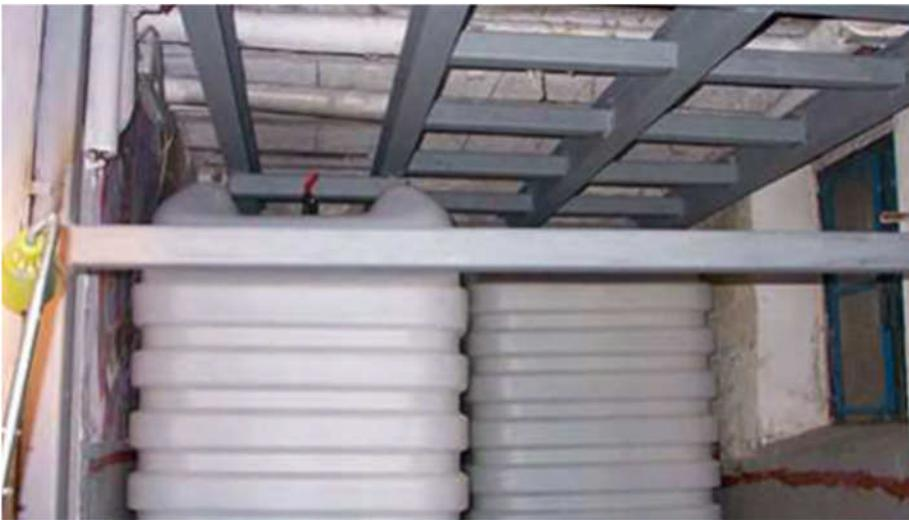
**ABBILDUNG 15: HEIZÖLTANKANLAGE MIT AUFTRIEBSSICHERUNG (QUELLE: HOCHWASSERSCHUTZFIBEL, 2018)**
